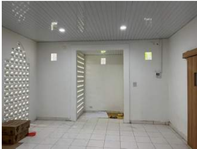
Pembangunan Pagar SLBN tanjung Pandan
